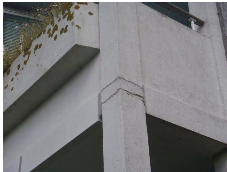
Illustration 10. Eksempel på revner ved top af altansøjle.
