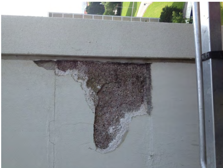
Illustration 5. Nærfoto af afskalning efter nedtagning.
