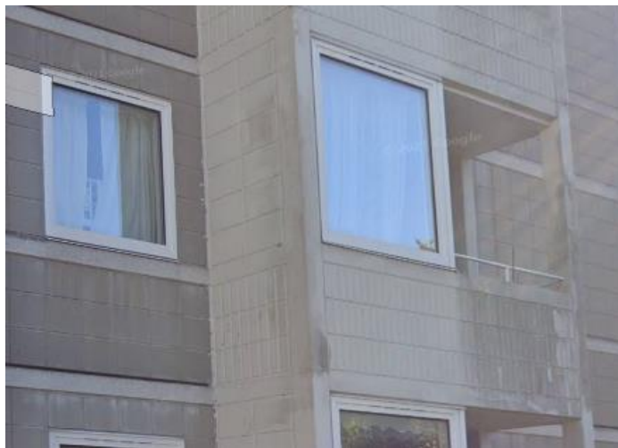
Gavl i karnap udformet som betonelementvæg.
