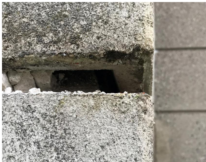
Fod af søjleportal udformet med lodret bevægelsesmulighed
