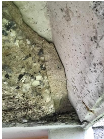
Opbygning altanplade inkl. bærende betonplade
