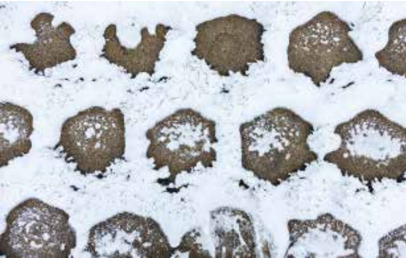
C.Th. Sørensen udviklede en ny flise i beton, som han kaldte Bellahøjflisen og brugte overalt på pladserne og stierne i området. Flisen, som stadig er i produktion, er sekskantet og støbt med en lille pilhøjde, der gør, at vandet kan løbe af. På grund af den sekskantede form efterlades stierne uden en skarp, lineær afslutning, og det gør fliseområderne til en integreret del af landskabet.
