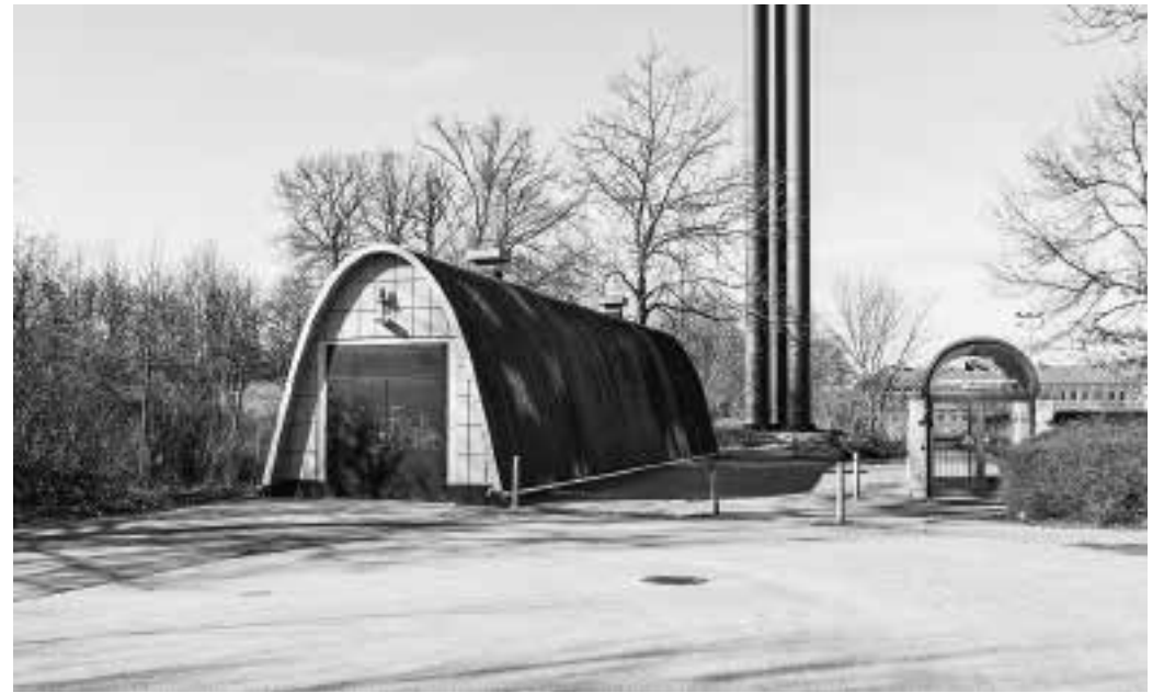
Varmecentralen i Bellahøj Nord er delvist nedgravet, kun en lille del af anlægget kan ses i bebyggelsen.
