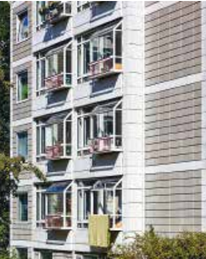
Den mest markante del af facaderne udgøres af altanerne, der er udformet som et stort sammenhængende element, der som en risalit springer frem fra facaden i husets fulde højde. Risalitten er kantet af en bort af lyse fliser, hvilket understreger, at det er en selvstændig del af facaden.
