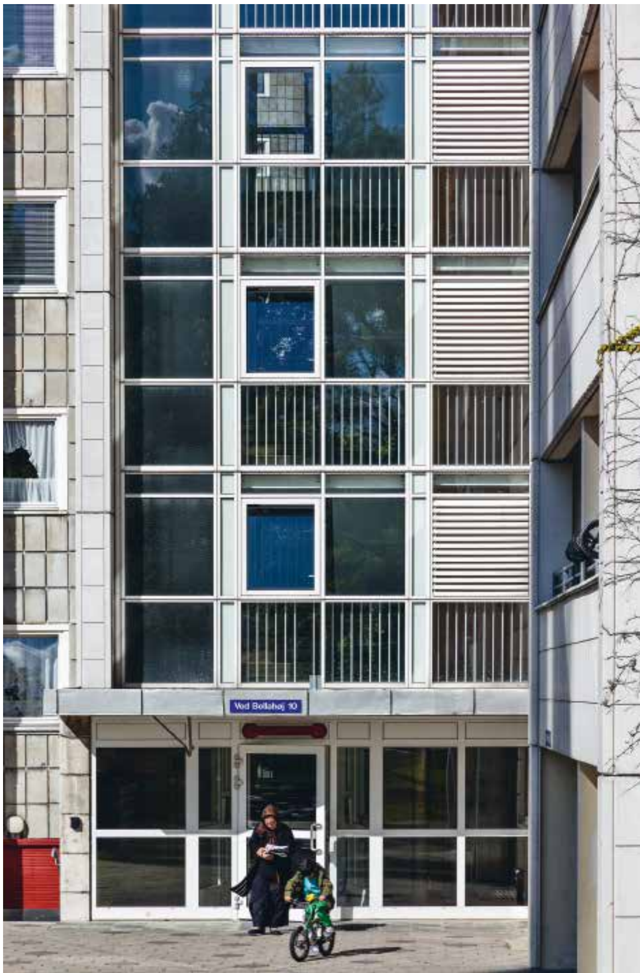
Kompositionen af trappetårnets glasfacade er detalje- og oplevelsesrig med sine felter af transparente og lukkede partier. De vandrette lameller skjuler luftslusen mellem trapperum og lejligheder.
