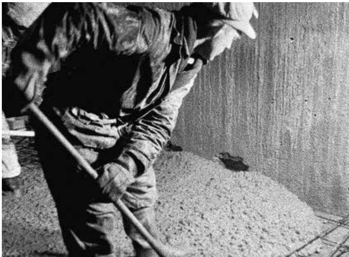
øverst Både fsb og AKB brugte glideforskalling til at opføre deres bygninger.
