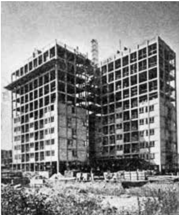
Kalltonhusenes konstruktionsmetode kan tydeligt aflæses af facaden: Et jernbeton-skelet af præfabrikerede søjler og dragere, der blev støbt sammen på byggepladsen. Facadefelterne blev derpå udmuret med gule mursten.
