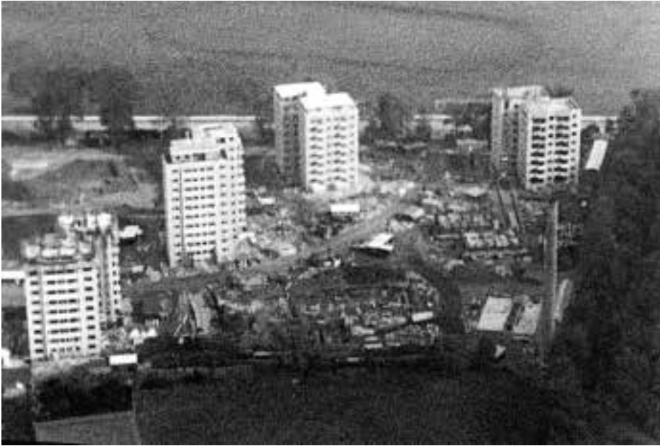
Fotografiet viser to af fsb's bygninger og to af AKB's bygninger, der alle blev opført i glideforskalling. I baggrunden ses Bellahøjvej og Bellahøjmarken. I forgrunden ses varmecentralens skorsten, og nederst i højre hjørne anes konturerne af friluftsteatret.
