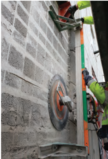
Nedrivning af lignende facadeopbygning på AKB Bellahøj med nulpunktsav
